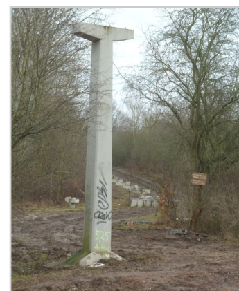
Baustelle der EVH am Heiderand
