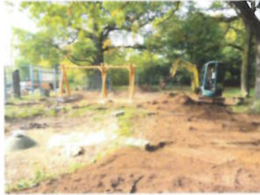
Baubeginn am Spielplatz „Alte Eiche“
