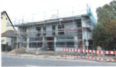
Baustelle an der Eislebener Straße 57
