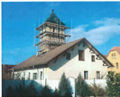
Reparaturarbeiten am Turm der ehem. „uralten Schule“ in der Eislebener Straße
