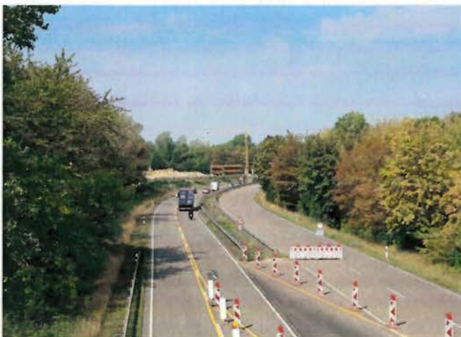
Blick von der Brücke auf die Baustelle Kreuzung B 80.
