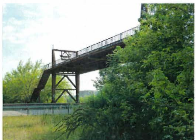
Blick auf die Seilbahnbrücke von der Seite des Steinbruchsees
