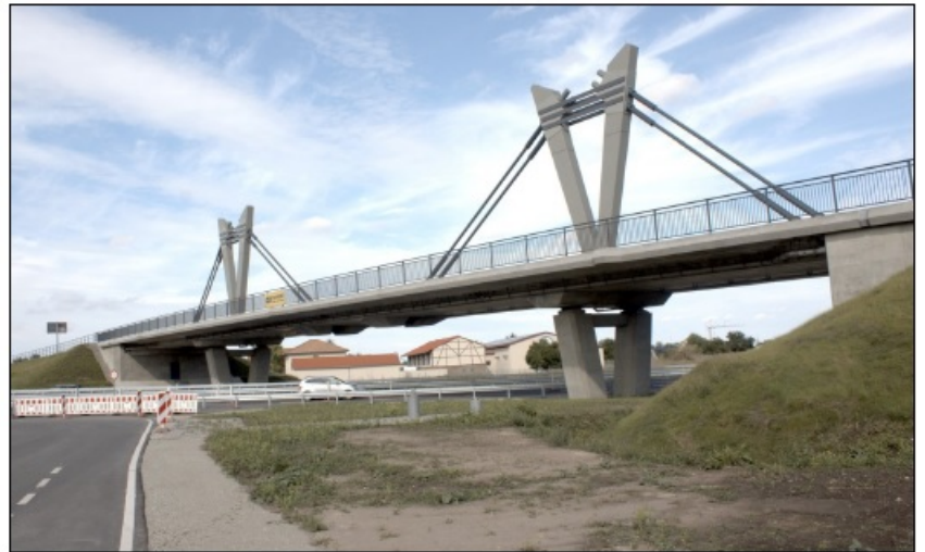
Das Golden Gate von Nietleben - das neue Eingangstor zur Stadt - die Brücke über der B 80 kurz vor der Eröffnung
