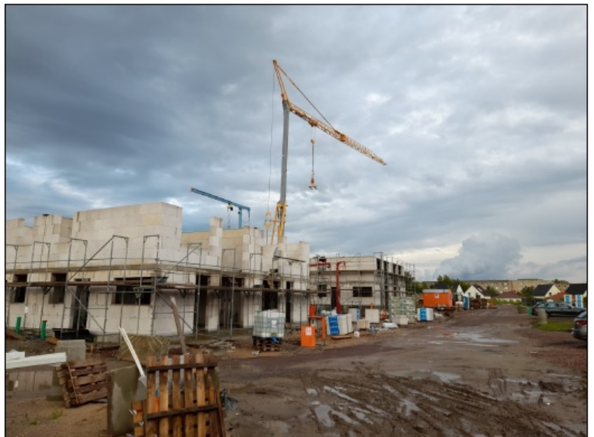
Baustelle auf dem Gelände des ehem. Zementwerkes. Hier entstehen Ein- und Mehrfamilienhäuser unter der Bezeichnung „Heideviertel“. Weitere Informationen zu diesem neuen Wohngebiet gibt es im nächsten Heft.
