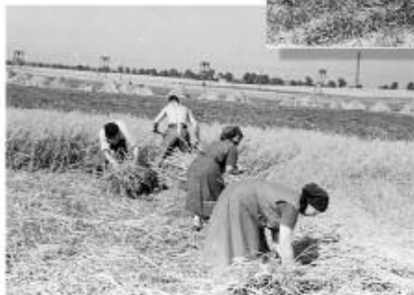
Getreideernte Bauer Wagner im Hintergrund: die Seilbahn Steinbruch - Zementwerk
