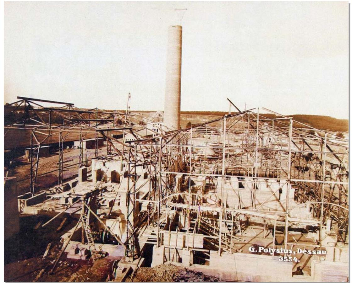
Erste Bauphase 1910 - Blick nach Norden. Im Vordergrund rechts das spätere Maschinenhaus, links die Rohstoffaufbereitung Kalkstein. Im Hintergrund entsteht das Ofenhaus, der erste Schornstein ist bereits gebaut. Am Horizont sichtbar die Grube Neuglück und die Heide.
