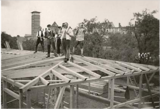
Notwohnungen Gemeinde Nietleben (1937 oder 1938) Windmühlenstraße - später wurden die Baracken als Hortgebäude genutzt
