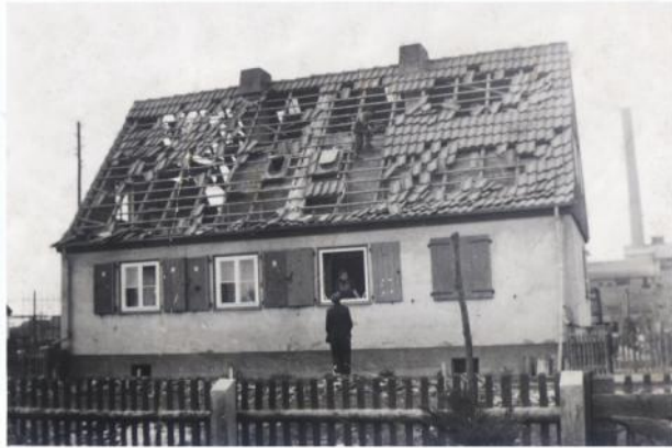
Am 24. März 1944 wurde die Siedlung Neuglück bei einem Bombenangriff beschädigt
